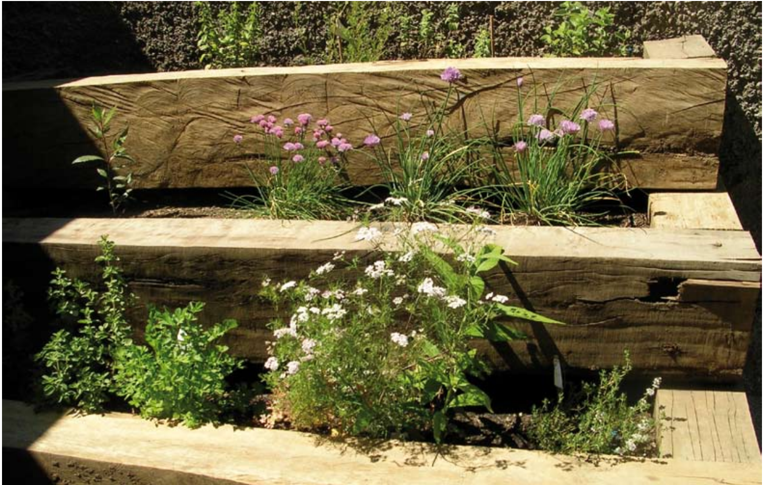
Jardinera Durmientes - Contención Diseño y Construcción MM Paisajismo Ltda.
